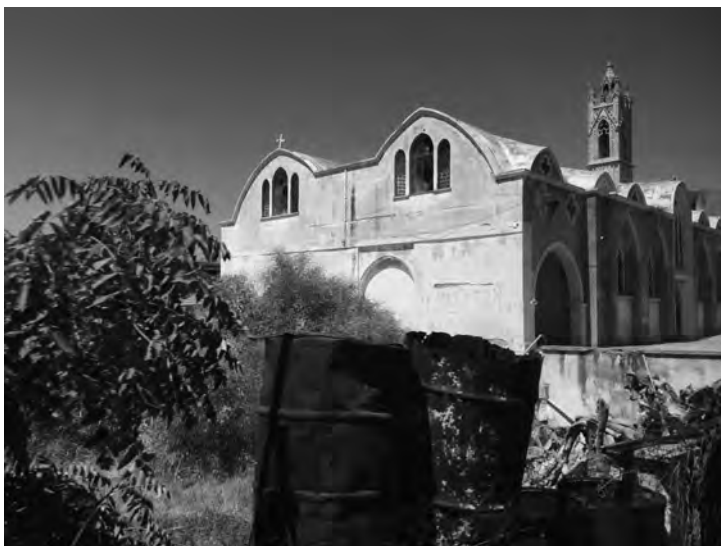
Fot. 8. Zrujnowana cerkiew w opuszczonej Varosy
